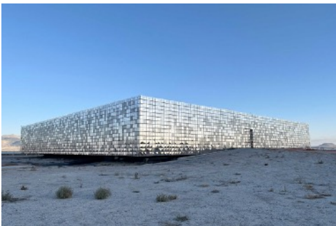
Karapınar GES Scada - Konya TR
