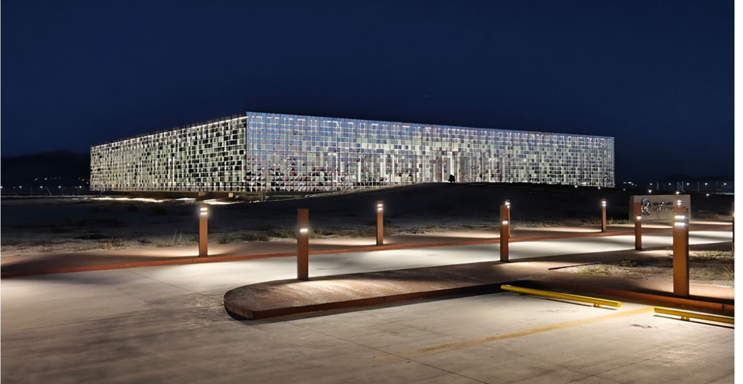
Karapınar GES Scada Binası Konya | ukonstudio 2024
