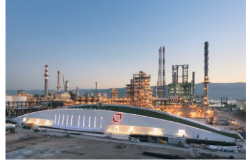
Tüpraş RUP Binası - İzmit TR
